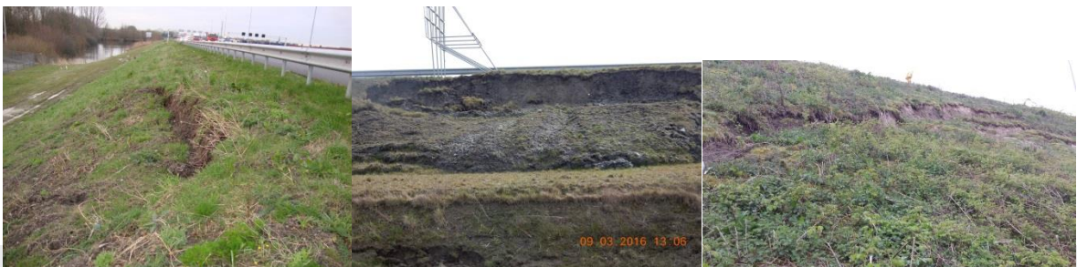
Foto: Afschuiving van talud.
