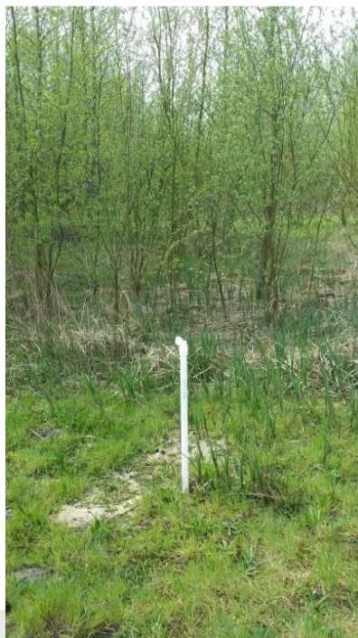
Foto: Monitoringsvoorziening kwetsbaar: peilbuis zonder mantelbuis.
