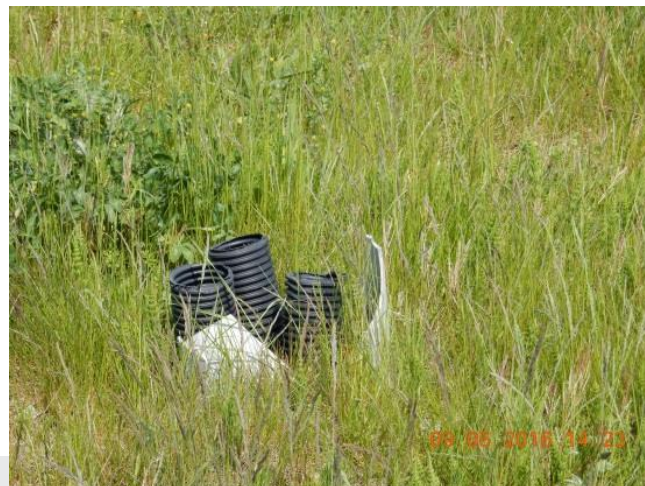
Foto: Mantel om drainageleidingen beschadigd.
